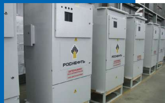
Станция управления погружными насосами
